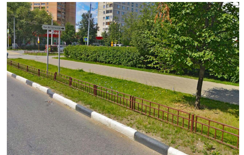
Газонное ограждение Тип 2 (110 м.)
