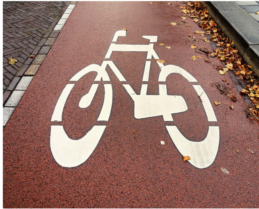
Наименование: Асфальтобетонное покрытие велодорожки
